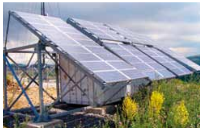
Фотоволтаици на базова станция на GLOBUL
